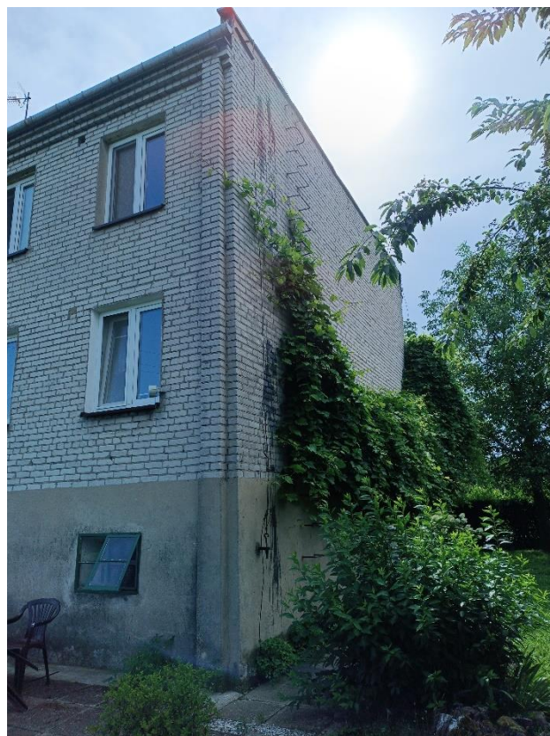
Widok na boczną elewację
