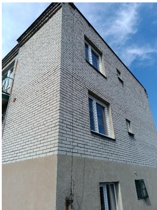
Widok na boczną elewację
