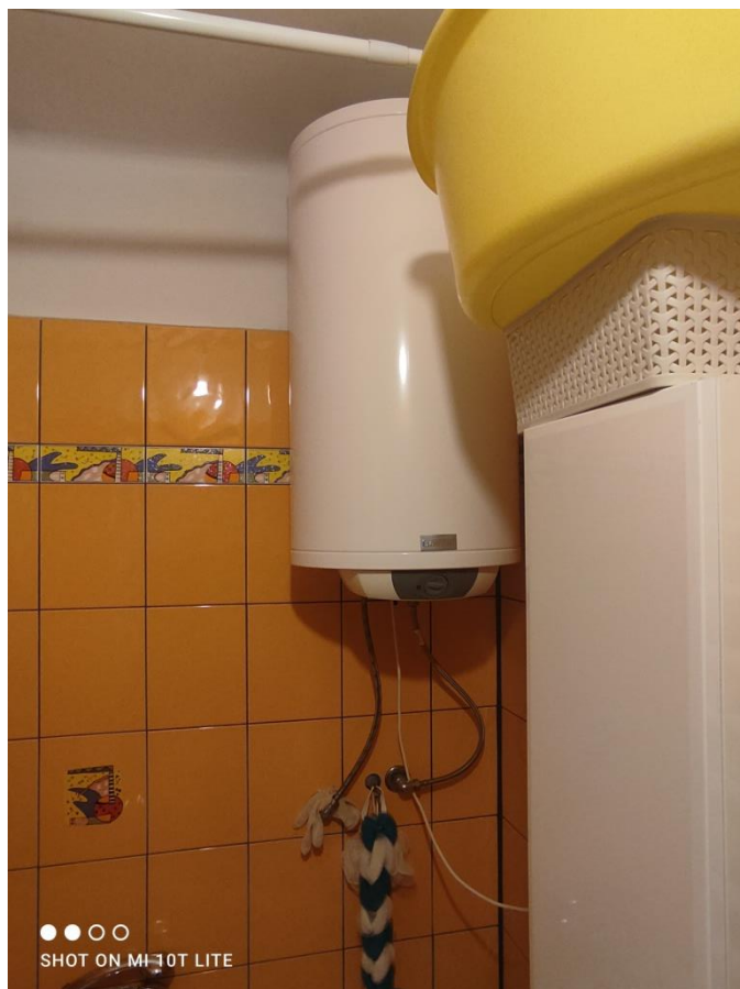
Widok lokalnego podgrzewacza c.w.u. w łazience jednego z mieszkań
