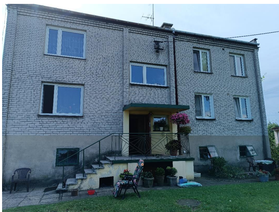
Widok na tylną elewację z wejściem do budynku
