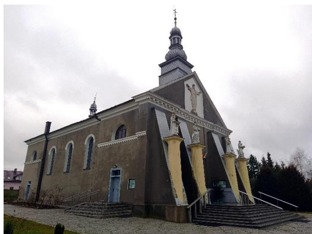
ZDJĘCIE 1. KOŚCIÓŁ PAR. PW. ŚW. BARTŁOIMEJA APOSTOŁA
